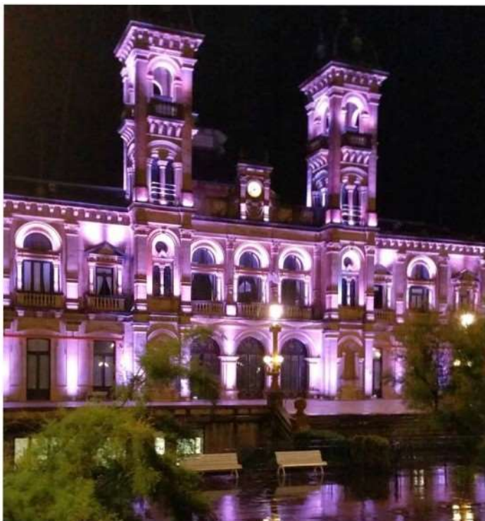
Ayuntamiento de San Sebastián. Iluminación de la fachada principal del Ayuntamiento de San Sebastián con tecnología RGB.)
